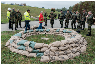
Abb.98: Maßnahmen zur Deichsicherung ‚Fangedamm‘ (links) und ‚Ringdamm‘ (rechts) (Fotos: Hochwasser Akademie, Wiesbaden)
