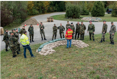
Abb.98: Maßnahmen zur Deichsicherung ‚Fangedamm‘ (links) und ‚Ringdamm‘ (rechts) (Fotos: Hochwasser Akademie, Wiesbaden)
